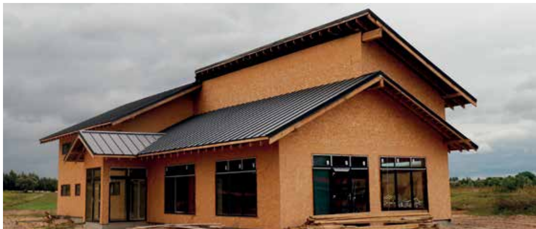
Figura 75 - Construção em placas OSB
