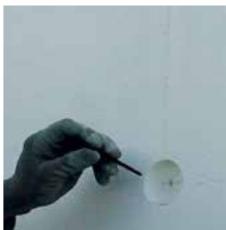
Figura 96 - Colocação da bucha de fixação
