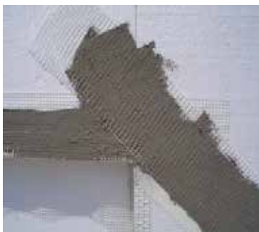
Figuras 104 e 105 - Reforço dos ângulos nos vãos descompensados e redes de reforço. Evita fissuração e aumentam a resistência ao choque
