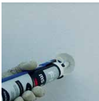
Figura 97 e 98 - Revestimento das buchas de fixação mecânica com EPS
