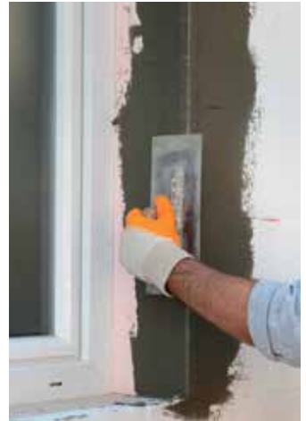
Figura 102 - Pormenor do reforço de arestas
