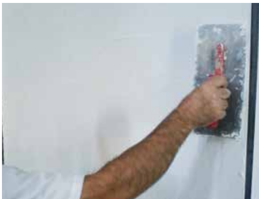
Figura 109 - Aplicação do acabamento (aumenta a resistência e durabilidade)
