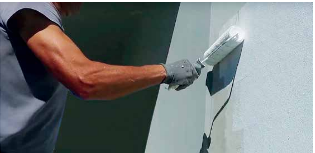
Figura 108 - Aplicação do Primário
