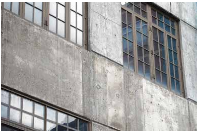
Figura 71 - Fachada de betão
