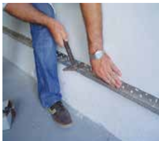
Figura 79 e 80 - Colocação do perfil de arranque.
