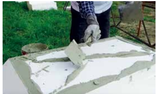
Figura 83 - Aplicação da ARGAMASSA THERMINNOV perimetral com pontos
