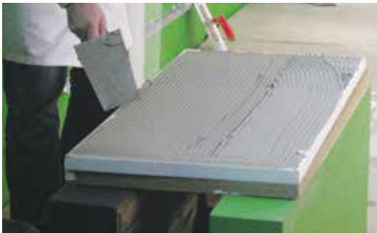
Figura 82 - Aplicação da ARGAMASSA THERMINNOV por barramento total
