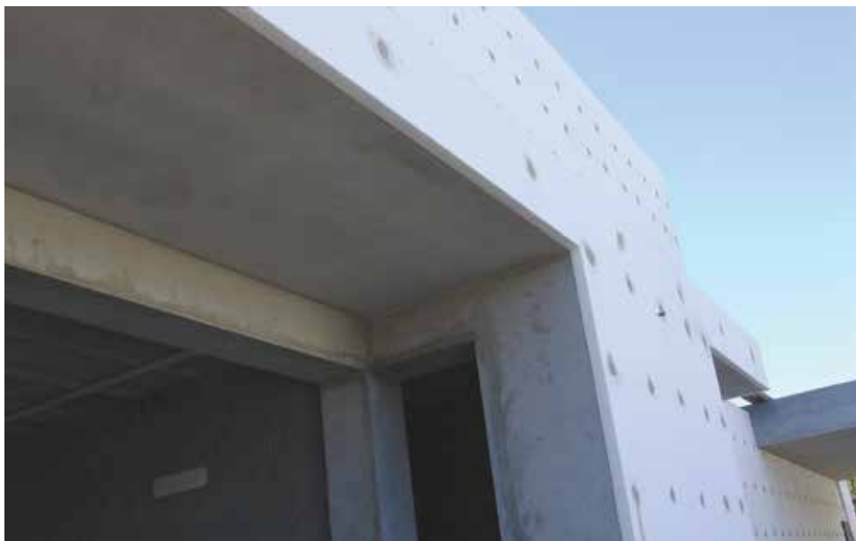
Figura 69 - Pormenor de obra com o Sistema ThermoInnov
