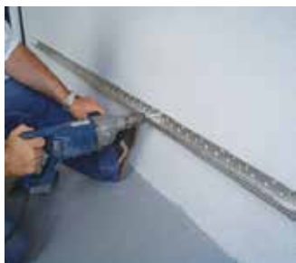
Figura 79 e 80 - Colocação do perfil de arranque.
