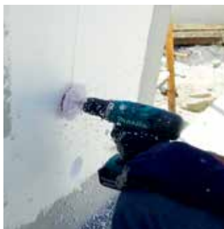
Figura 94 e 95 - Fixação mecânica das placas
