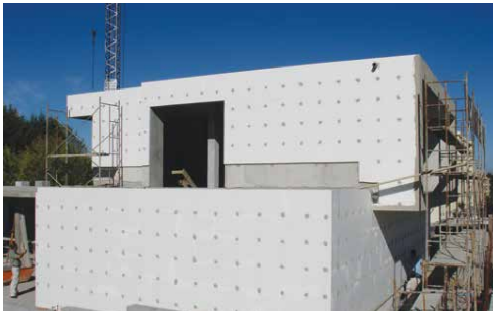
Figura 1- Obra com o sistema de isolamento térmico pelo exterior
