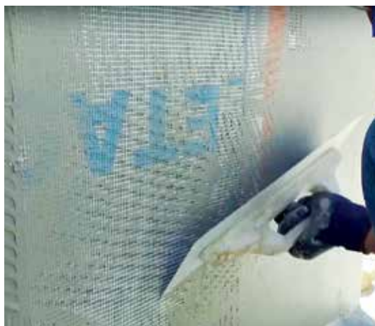
Figura 106 - Barramento com ARGAMASSA THERMINNOV, com talocha dentada, facilita o assentamento da rede e colocação da armadura que confere resistência mecânica ao sistema, contra choques e fissuras
