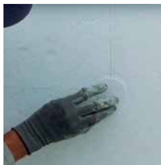
Figura 97 e 98 - Revestimento das buchas de fixação mecânica com EPS
