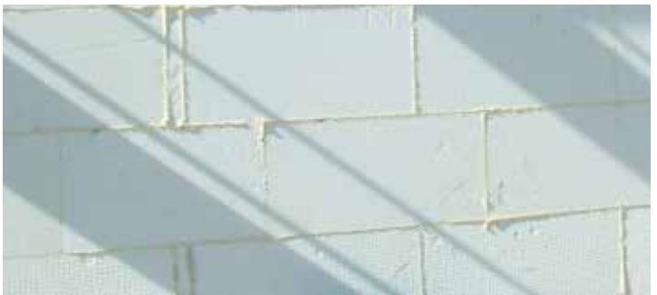
Figuras 89 e 90 - Preenchimento das folgas com pedaços de AIRPOP ou espuma PU de baixa expansão
