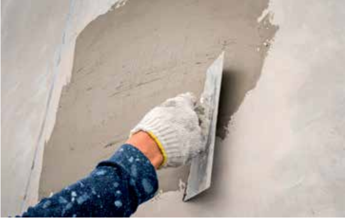
Figura 107 - Barramento final com ARGAMASSA THERMINNOV
