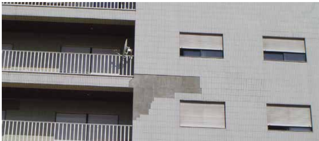
Figura 74 - Fachada com revestimento cerâmico
