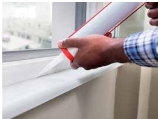
Figura 87 - Vedação de janela
