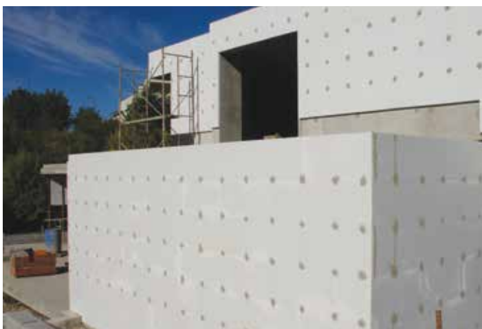
Figura 99 - Revestimento das buchas de fixação com ARGAMASSA THERMINNOV
