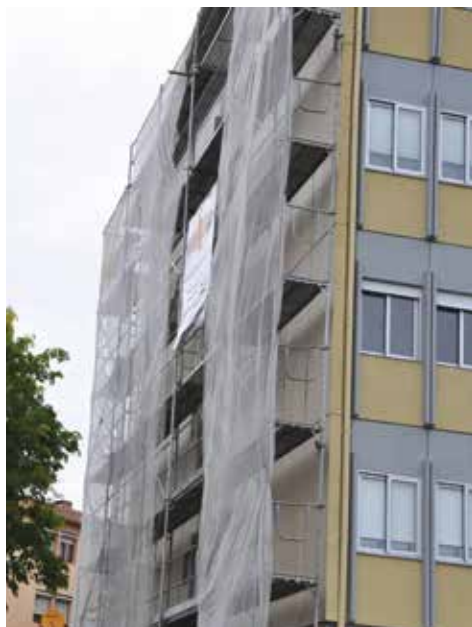
Figura 70 - Estrutura de andaime com cobertura
