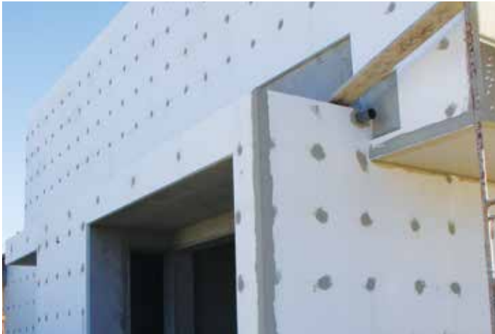
Figura 101 - Reforço de arestas
